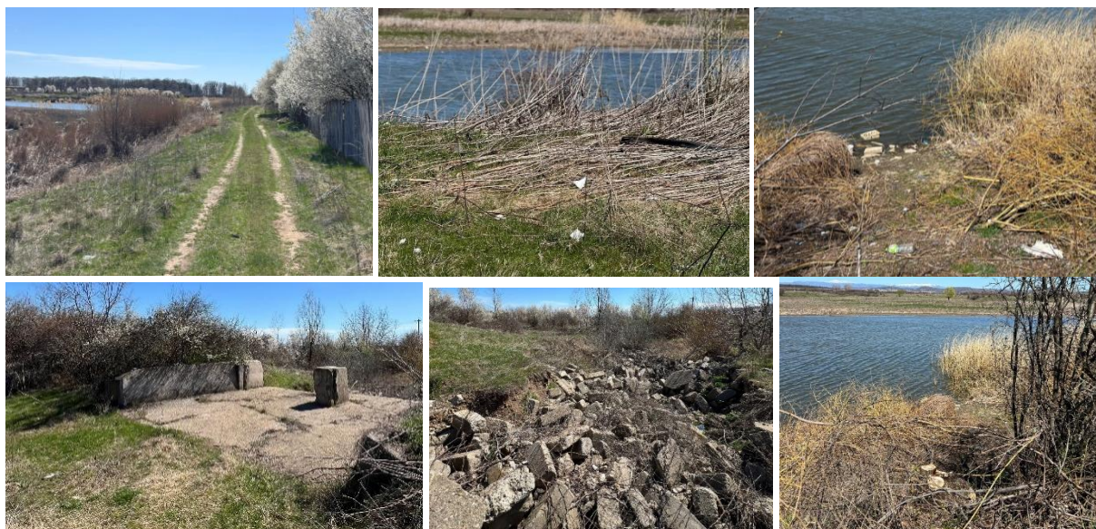
Figură 9 – Analiza disfuncțiilor la nivelul vegetației
